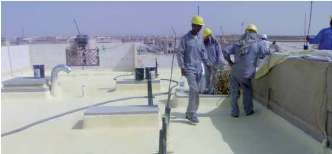
Roof Spray PU
